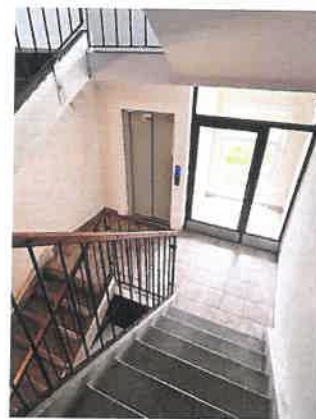
Schodisko a výťah
