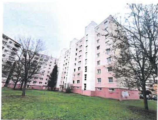
Bytový dom, pohľad zadný
