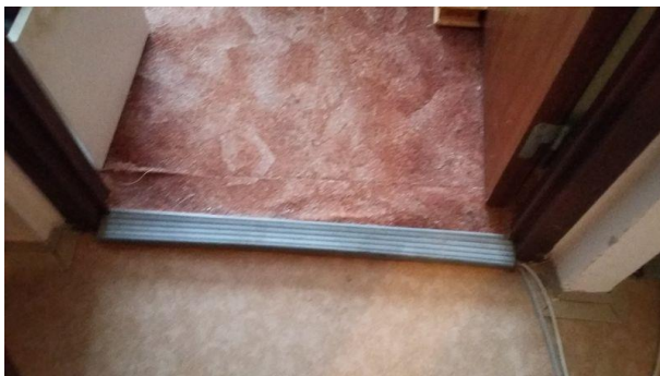
Podlahy – pôvodný stav
