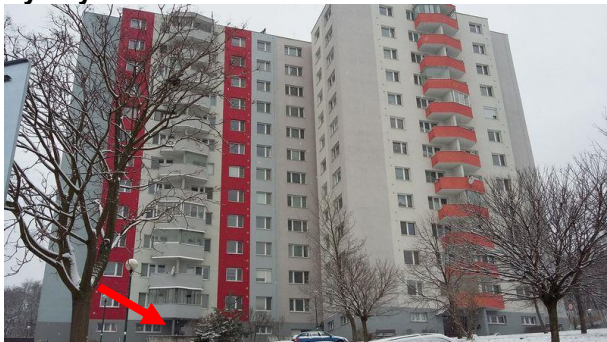
Bytový dom s. č. 3128 a s. č. 3129, pohľad V, vchod č. 8
