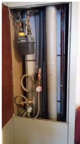
Inšalačná šachta v chodbe, merač spotreby plynu
