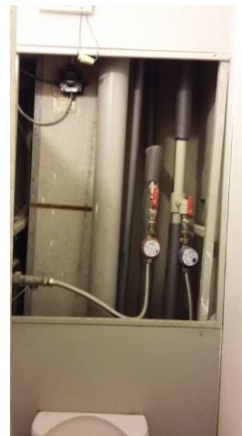
Inšalačná šachta vo WC, merače spotreby SV a TUV
