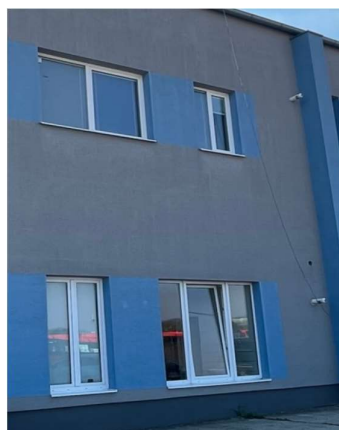
Fasáda, plastové okná a dvere
