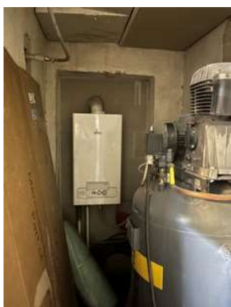
Kotol v prevádzke autoservisu
