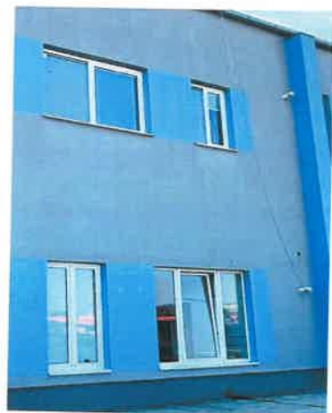
Fasáda, plastové okná
