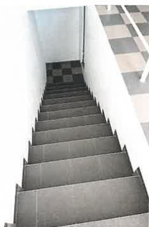
Schodisko na 2.NP
