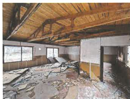
prevádzková budova na p.č. 5365/3 interiér
