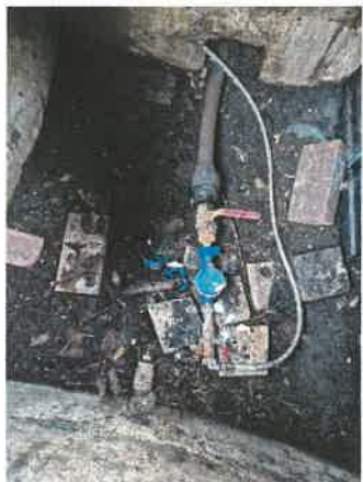
Prípojka vody a vodomerná šachta
